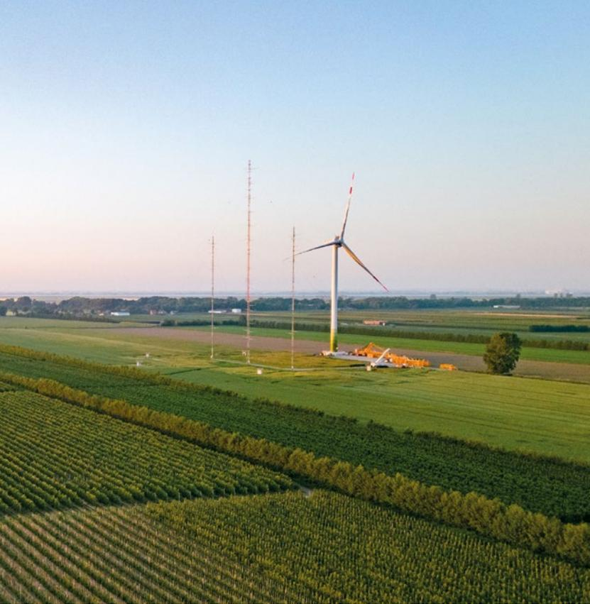
Im Forschungspark Wind-Validation (WiValdi) stehen zwei hochmoderne bis in 150 Meter Höhe reichende Windenergieanlagen in Hauptwindrichtung hintereinander. Das Szenario bildet die Zukunft ab, denn bei den aktuell geplanten hohen Ausbautzahlen von neuen Windenergieanlagen und -parks werden die Anlagen unvermeidlich näher zusammenstehen und sich bei unterschiedlichen Windrichtungen auch verschatten.
